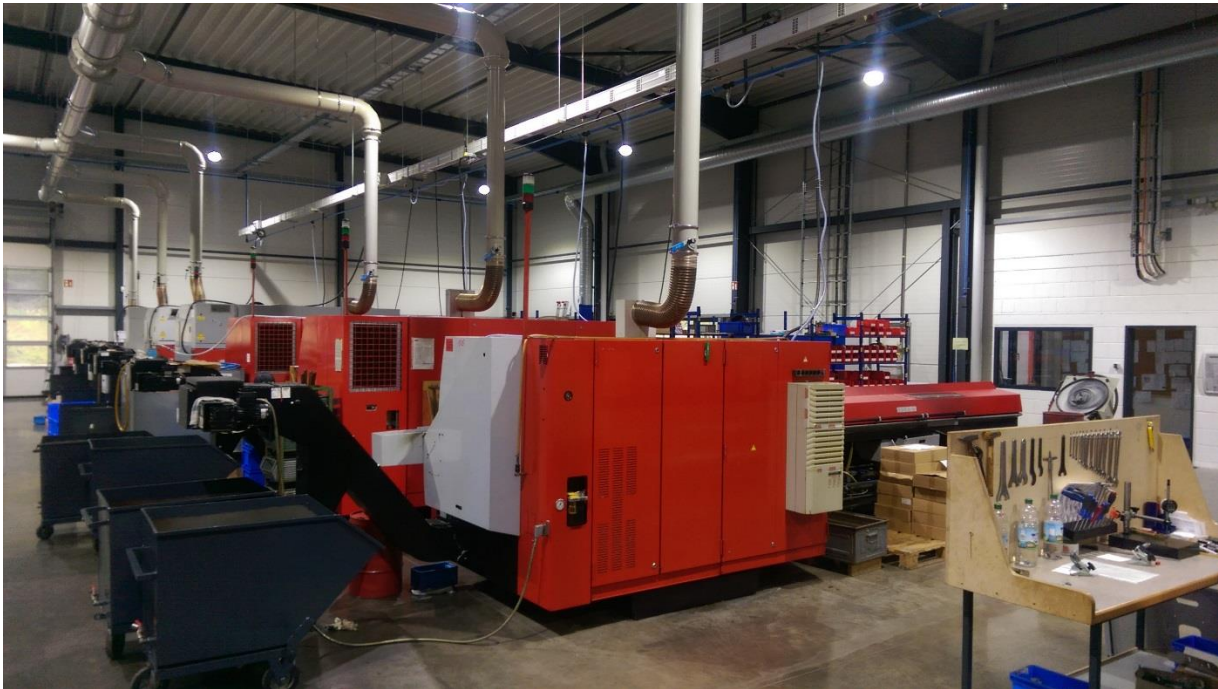
Bild: Zerspanung mit 12 Maschinen – 8.000m 3 /h
